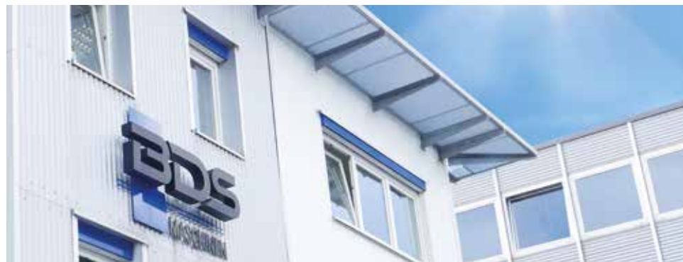
BDS-Firmenzentrale und Fertigung in Mönchengladbach
